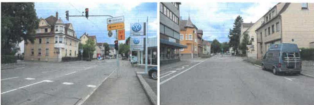
Abbildung 25: Die Marktstraße zwischen Einmündung Zeilstraße (links) und Kreuzung Bismarckstraße (rechts), Blickrichtung stadteinwärts.
