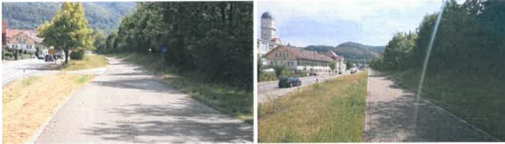
Abbildung 41: Blick von der Gemarkungsgrenze in Richtung Busspur am Ortseingang Lichtenstein ehemalige Trasse und heutige Busspur, Links der Gewerbepark.
