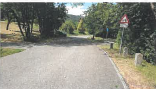
Abbildung 39: Kreuzung der Trasse mit der Straße Im Ehespach an der Gemarkungsgrenze Pfullingen/Lichtenstein. Die Trasse folgt dem jetzigen Radweg. Blickrichtung Pfullingen.
