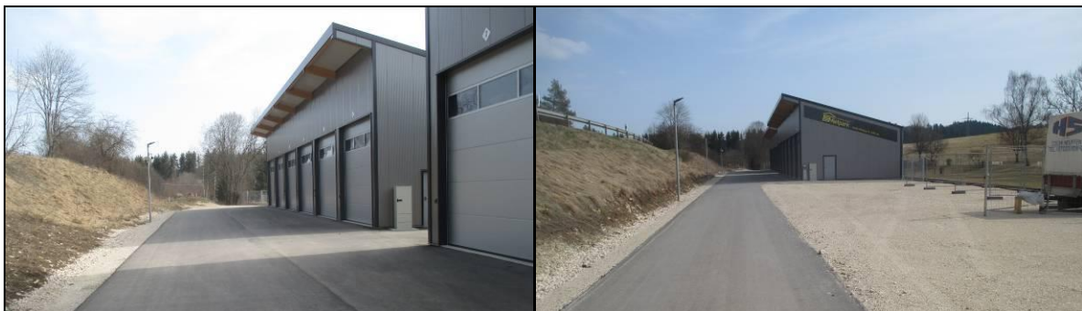
Abbildung 4 Garagengebäude und asphaltierte Zufahrt.
