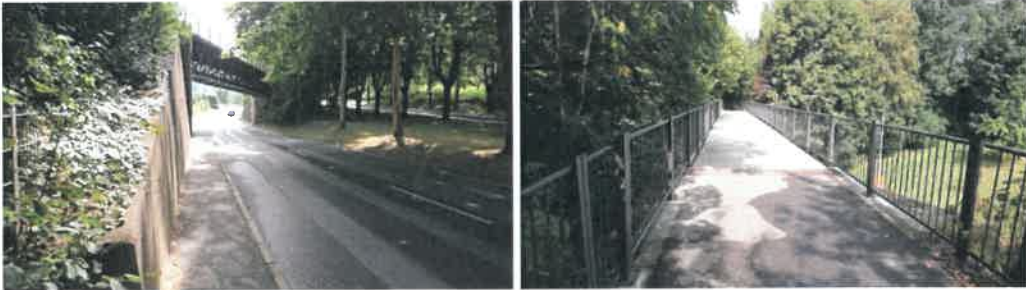
Abbildung 23: EÜ Klosterstraße, Ansicht von unten, Blickrichtung Lichtenstein (links) und von oben, Blickrichtung Pfullingen Bahnhof (rechts).
