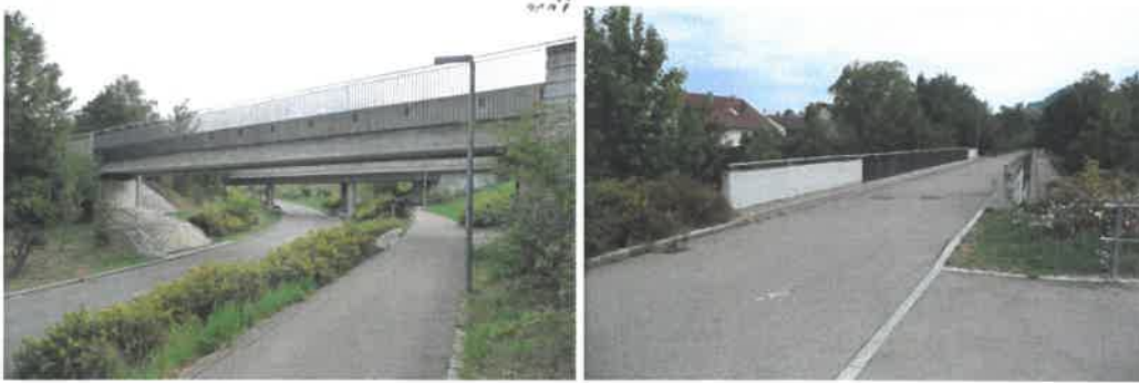
Abbildung 11: Wegbrücke über die Zeilstraße, im Hintergrund die Brücke der B 313 (links), Wegbrücke über die Zeilstraße mit Weg in Richtung Reutlingen (rechts).
