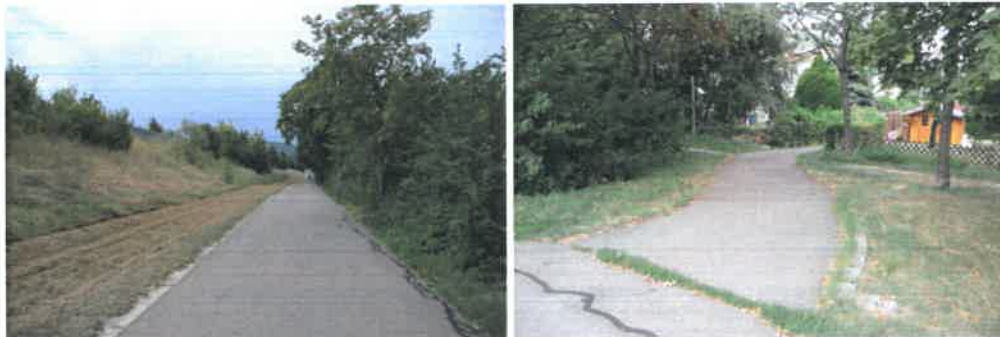
Abbildung 9: Neuer Trassenverlauf auf dem Rad- und Fußweg, mit Lärmschutzwall der B 313 links, Blickrichtung Pfullingen Bahnhof (links), Zugang zum Rad- und Fußweg von der Hauffstraße kommen, mit dazwischen liegender alter Bahntrasse (rechts).
