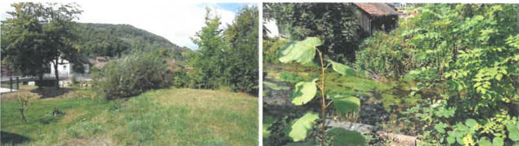
Abbildung 47: Alte Bahntrasse über die Echaz in Lichtenstein, Blickrichtung Unterhausen (links), Ehemalige Brücke über die Echaz, im Vordergrund ein Widerlager (rechts)
