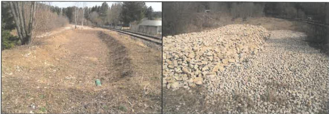
**Abbildung 3** Retentionsmulde im Osten (links) und Steinriegel (rechts).
