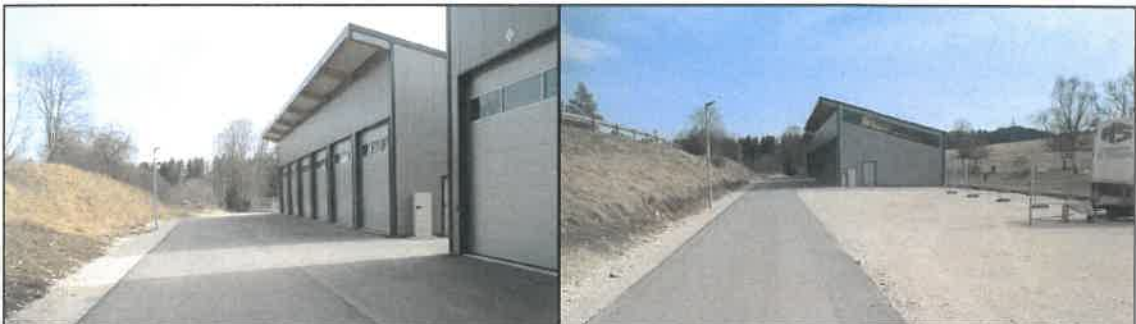
Abbildung 4 Garagengebäude und asphaltierte Zufahrt.
