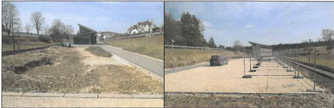
Abbildung 2 Freiflächen im Mittelteil: links Retentionsmulde (Blickrichtung West), rechts Schotterfläche (Blickrichtung Ost. Im Bereich der Schotterfläche ist die Nachverdichtung mit weiteren Garagengebäuden geplant.
